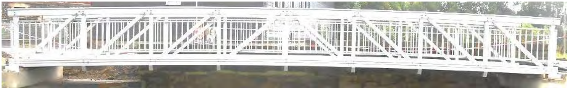
Radwegbrücke Greifenhainer Fließ
